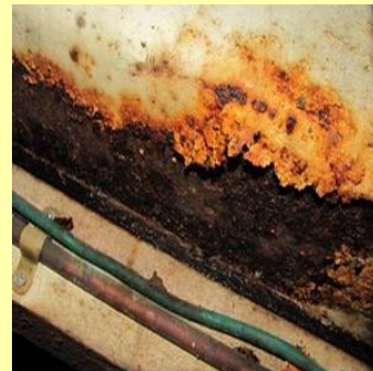
Endoscoop foto van de onderkant van de tank
