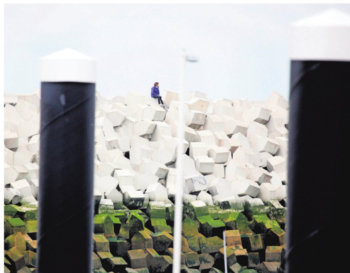
▲ Op de nieuwe strekdammen werden, voor het eerst in ons land, Xblocs gebruikt.
