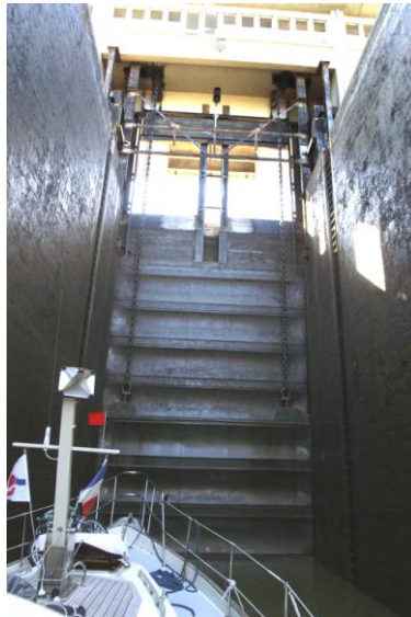
Grote deuren met een verval van 10.76 mtr.
